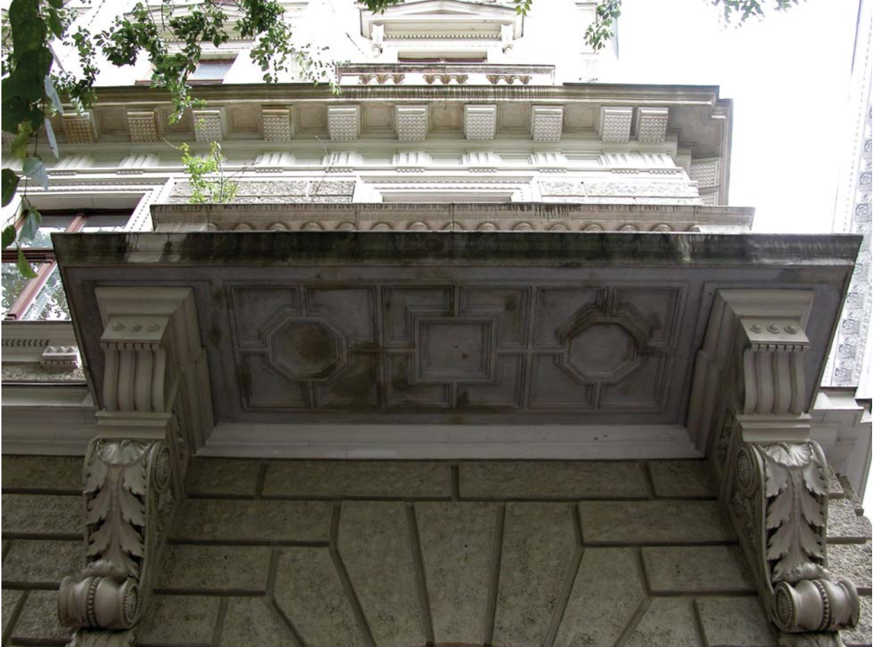
Alul is faragott kőlapból készített Andrassy úti erkély, fotó: Lőrinczi Zsuzsa nyitókép képfelirattal
