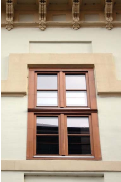
Az eredetitől eltérő kialakítások, alumínium vízvetők, vastag profilok, elfűrészelt tokosztó, bukóablak, bedőlő oszlopdíszszel
