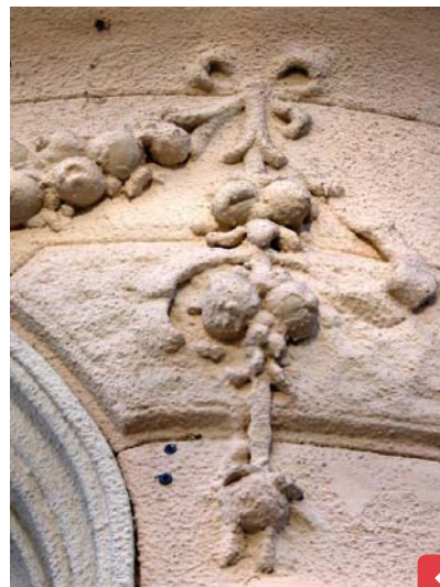
Eredeti, simított vakolat egy VI. kerületi lakóépületen kőporos vakolattal eltakart tagozatok és épületedísz, mint rossz megoldás
