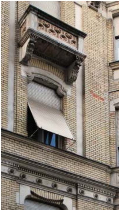
Esslingeni redőnyök kitémasztható karral
