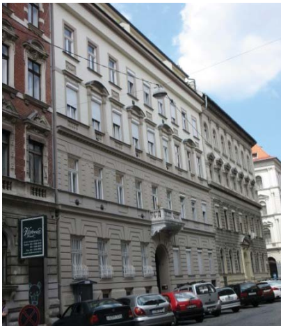
Igényesen felújított épület, az utcáról alig észrevehető, lépcsőzetesen visszaléptetett új emeletráépítéssel, Eötvös utca 44.
