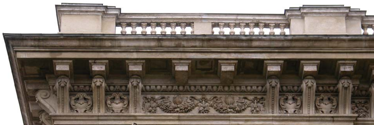
Balluszteres attikafal, mögötte vezetett ereszcatornával (attikacsatorna)
