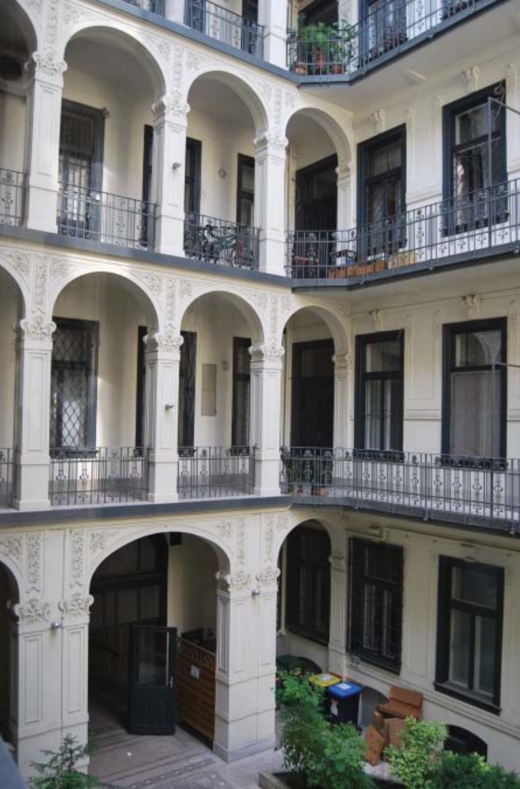
Ó utca 6., loggia és függőfolyosó
