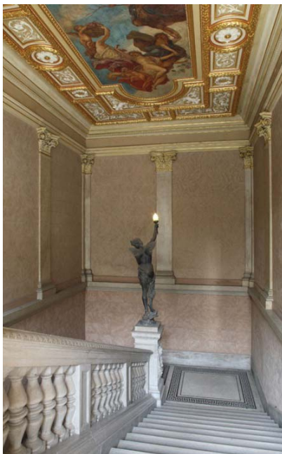
Legfelső emeleti megőrzendő díszített mennyezet a lépcsőházban, Andrássy út 3.
