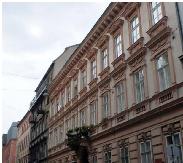
Egyediséget megőrző homlokzat-felújítás, Zichy utca 22.
