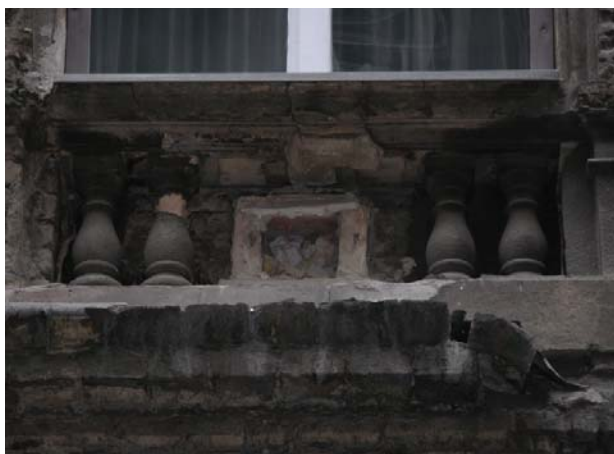
Parapet-konvektorok kivezetései a VI. kerületben
