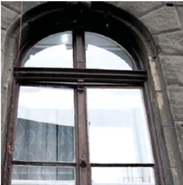
VI. kerületi eredeti és új egyrétegű, cserélt ablakok, ahol nem követi az új az eredeti kialakítást
