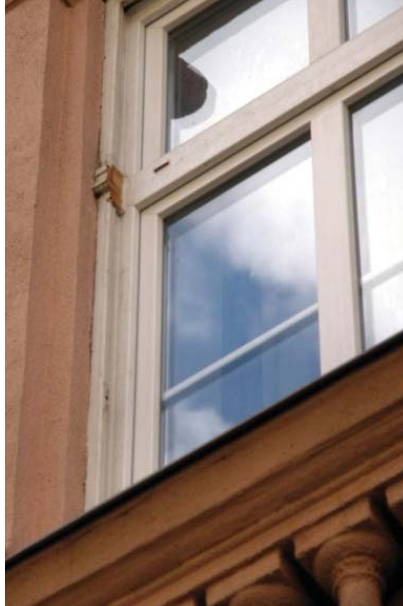
Az eredetitől eltérő kialakítások, alumínium vízvetők, vastag profilok, elfűrészelt tokosztó, bukóablak, bedőlő oszlopdíszszel
