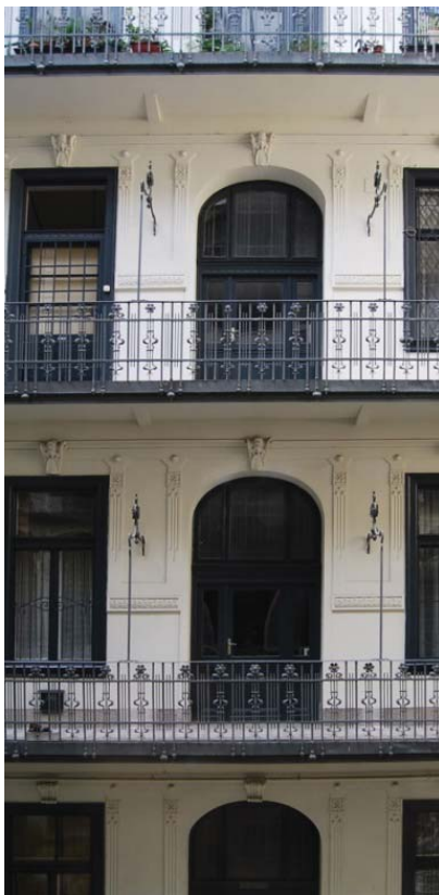
Ó utca 6. acélgerendákra ültetett függőfolyosó felújítva, egységes nyílászárókkal.
