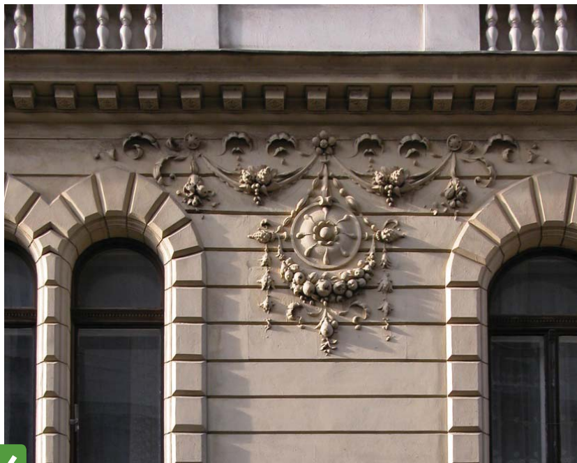
Eredeti, simított vakolat egy VI. kerületi lakóépületen kőporos vakolattal eltakart tagozatok és épületedísz, mint rossz megoldás
