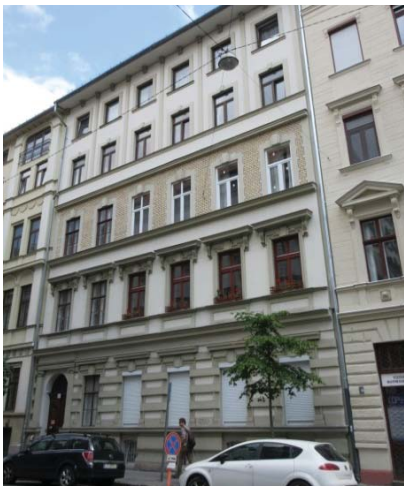
Az összképet meg nem bontó, kulturált, mértéktartó bővítés, ráépítés, Eötvös utca 49.
