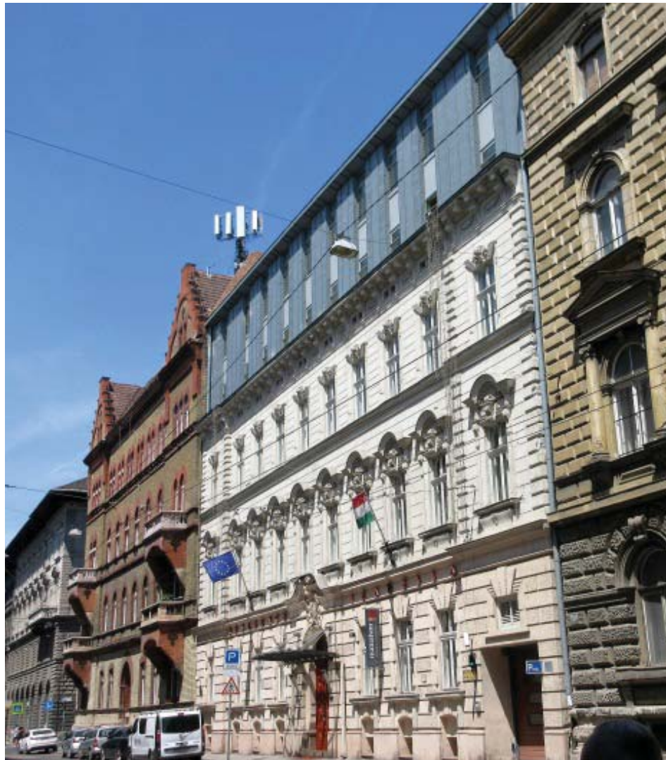
A meglévő épület tömegét kiegészítő, a szomszédos házak magasságához illeszkedő, értékmegőrző, mai szemléletű emeletráépítés, Izabella utca 61.
