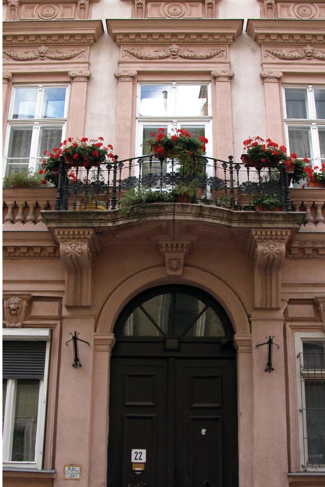
VI. kerületi lakóház 2 db kőlapból készült erkélye szintén megfaragott alsó felülettel
