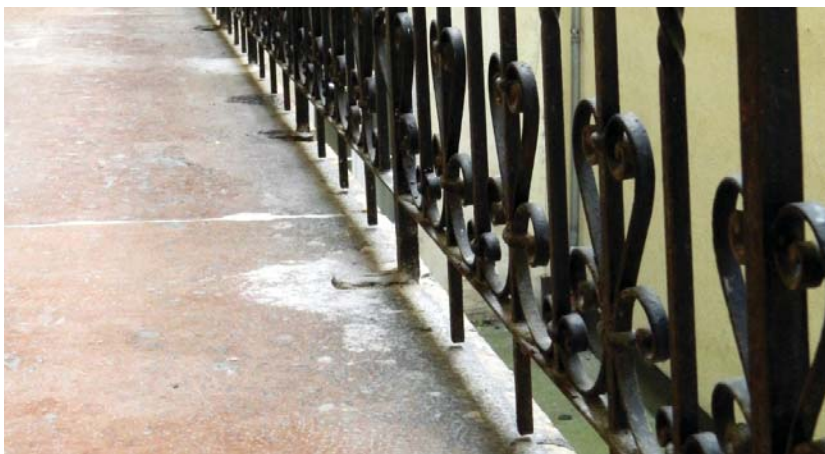
Dalszínház utca 10., Lázár utca 5, kőtömbös–kőkonzolos függőfolyosója, Nagymező utca 43. U acél élképzésű függőfolyosója
