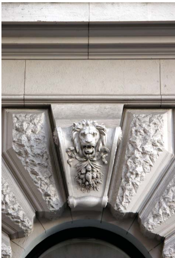
Zárókődíszek, kváderézések megőrzött felülete
