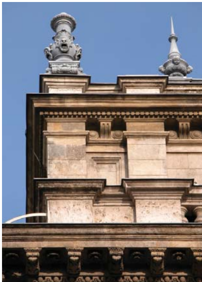
Bádogos munkák VI. kerületi épületeken; csúcscsúcsok, rézből készített függőleges csatorna, hófogók
