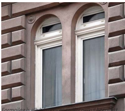
Formailag is elbírható, de a gipsz nélküli beépített, nem engedélyezhető - műanyag ablak
