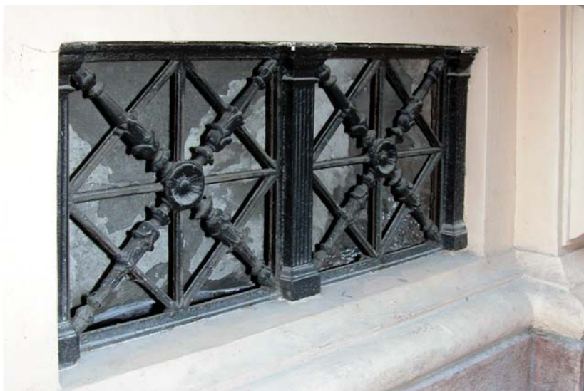
A szellőzés biztosítása megtartandó pinceablakkal, ráccsal, felújítandó kovácsoltvas rács, öntöttvas rács szép példája
