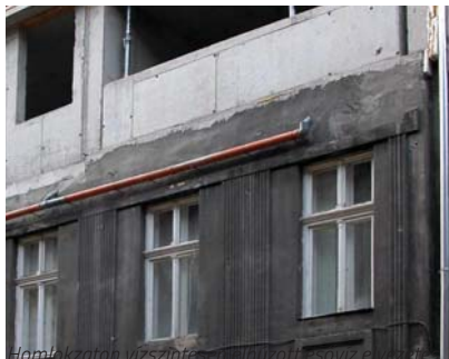
tiltott PVC szennyvízcső bádogcsartona helyett
