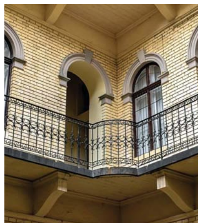
Teréz krt. 8., íves kibővítésű függőfolyosó
