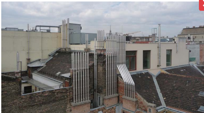
Tetőtáj zavaró kéményerdővel
