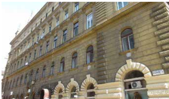
Dessewffy utcai, Jókai utcai homlokzatrészletek
