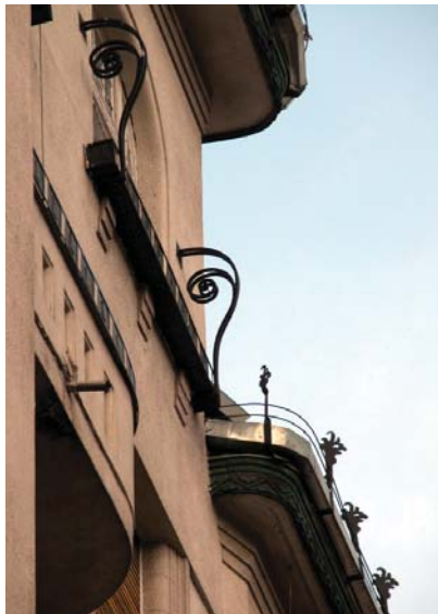
Bádogos munkák VI. kerületi épületeken; csúcscsúcsok, rézből készített függőleges csatorna, hófogók
