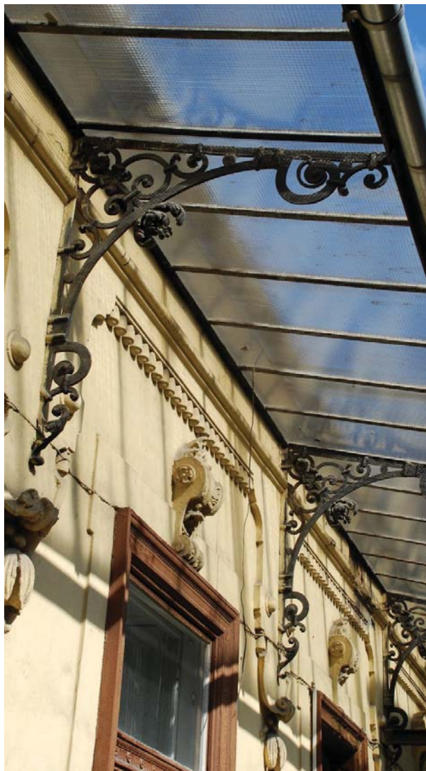
Liszt Ferenc tér 4., függőfolyosó üvegezett fedése
