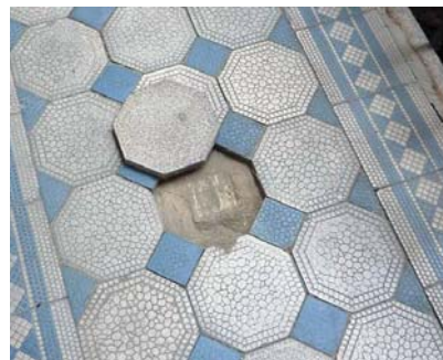
Cementlapburkolatú, U acél élképzésű függőfolyosó
